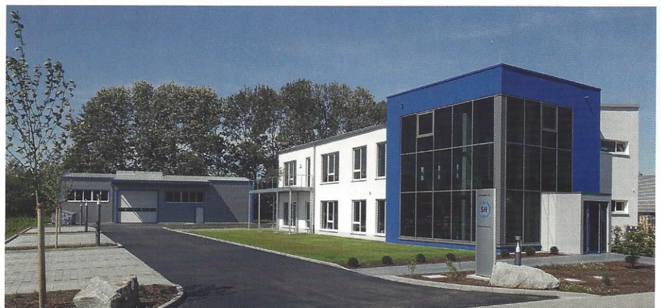
Neue Firmenniederlassung in Bühl: Zur Steuerung betriebswirtschaftlicher Prozesse nutzt Hallasch seit vielen Jahren die ERP-Branchensoftware esoffice. Mit esmobile wurde zudem jüngst eine mobile Außendienstlösung eingeführt. Bild: Hallasch Aufzüge e.K.
